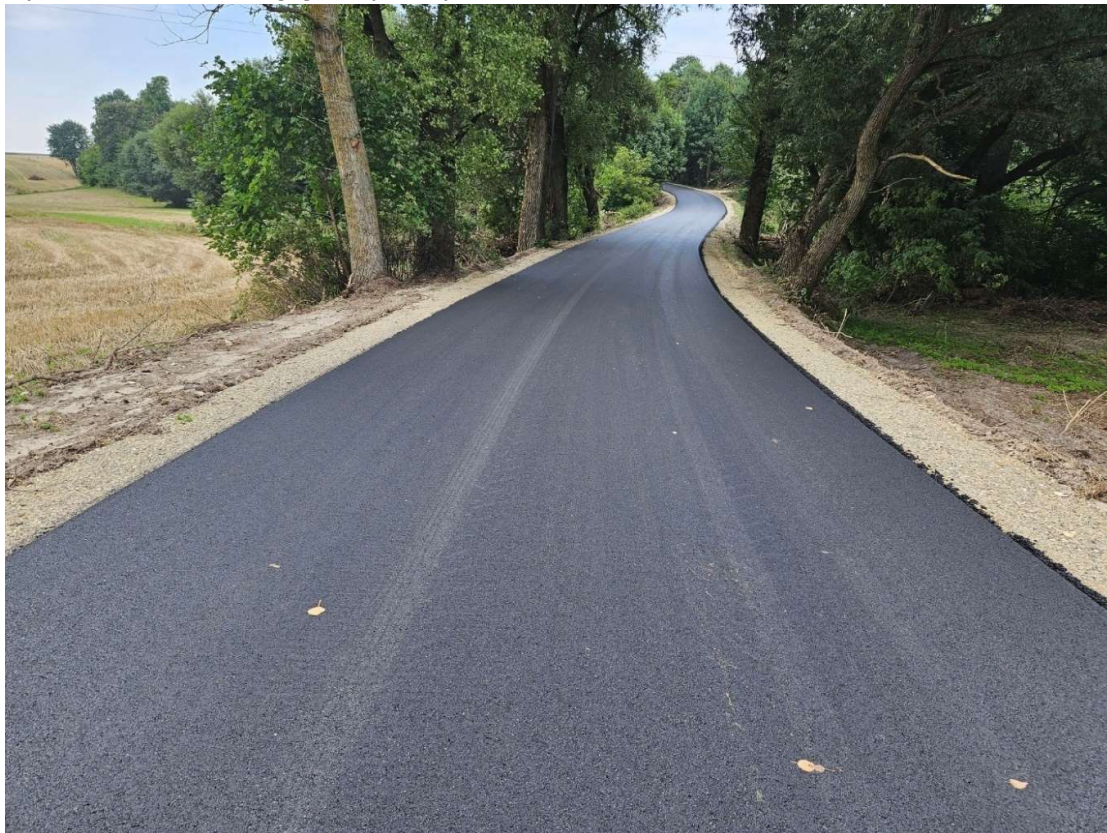
Zdjęcie 6. Przebudowa drogi gminnej w miejscowości Gielczew-Kolonia
