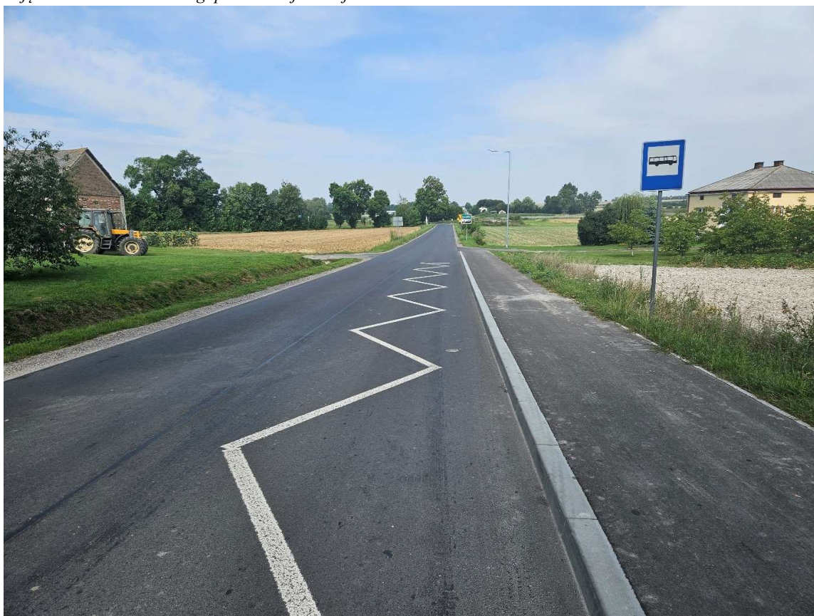
Zdjęcie 5. Przebudowa drogi powiatowej w miejscowości Guzówka.
