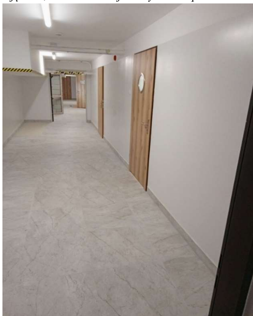
Zdjęcie 8,9. Modernizacja budynku Zespołu Szkół w Wysokiem
